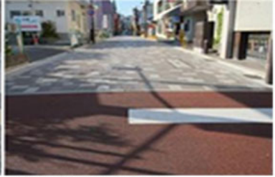
▲커뮤니케이션 존 내 컬러 포장 설치
