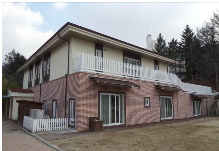
[그림 4-8] K-Water 물사랑 어린이집 그린리모델링 공사후 전경
